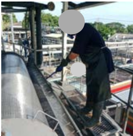
รูปที่ 2-4 การทำความสะอาด Rotary Screen
